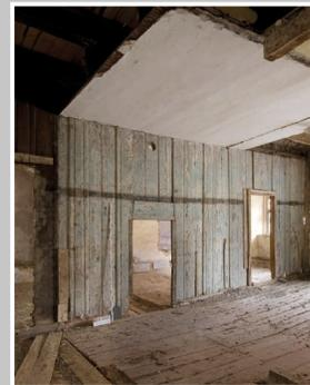
Das 2. Obergeschoss, mit der im Bestand größten vorhandenen Raumböhe innerhalb des Gebäudes und der gleichmäßigen Holzbalkenlage der Decke zum Dachgeschoss wird zukünftig das sogenannte **KLEINKUNSTPODIUM** mit 160 Sitzplätzen aufnehmen. Die auf dem Foto zu sehende Bohlenwand wird in das 1. Obergeschoss transloziert
